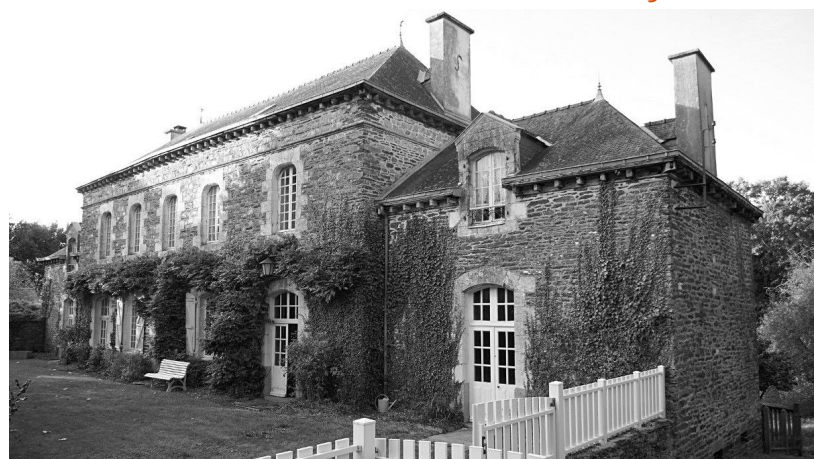
Manoir - Façade sud
