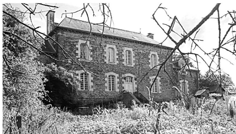
Manoir - Façade nord
